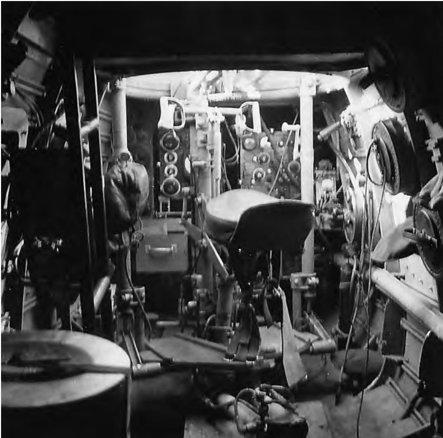
Talvisodan aikana saadut entiset RAF:n Blenheimit oli varustettu T1083/R1082-ase- malla. Konekivääritornin takana vasemmal- la on sarja lähettimen ja vastaanottimen vaihtokeloja, siitä oikealle vastaanotin, lähetin, lähettimen neutralointimittari ja sivuseinässä riippuantenni. Vastaanottimen alla on usein mainittu messinkikahvainen keittiölaatikko, jossa säilytettiin aseman lukuisia irto-osia.
